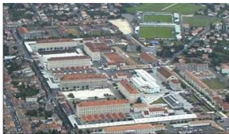
Vue aérienne du RIMa
