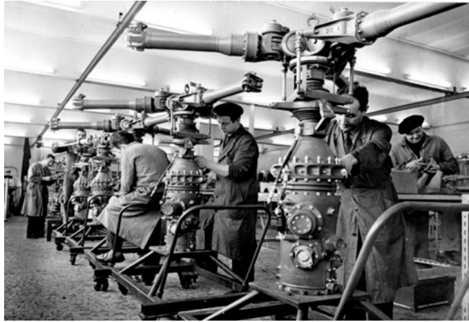
Figure 32 - La Courneuve. Chaîne BTP et moyeu Alouette II © Photo DR/Airbus Helicopters
