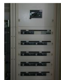
Armoire disjoncteurs communicants
