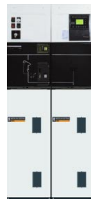
Cellule disjoncteur avec protection numérique Sepam
