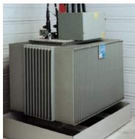
Transformateur de 2 000 kVA, 20 kV / 410 V
