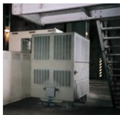
Transformateur Trihal avec enveloppe métallique IP 31
