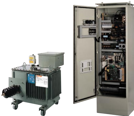
Transformateur et redresseur pour électrofiltres
