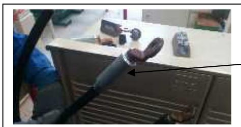
Positionnement de la cosse, laisser 5mm de conducteur nu dépassé de la cosse. Pensez à insérer un morceau de GRN 50-150 avant le positionnement de la cosse.
