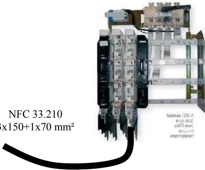
Pour un raccordement sur un départ monobloc du TUR, cosse à poinçonner Alu-cuivre :
