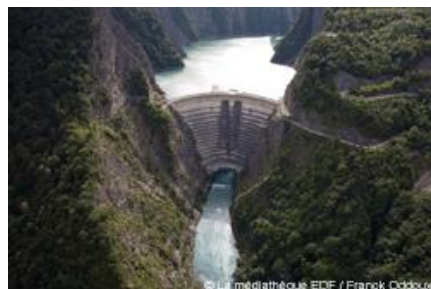
Barrage et retenue de Monteynard (Isère)
