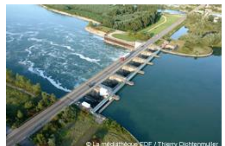
Centrale hydraulique d'Iffezheim sur le Rhin (Alsace)
