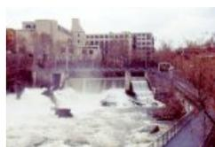
Construit vers 1910 sur la rivière Magog, à Sherbrooke, ce barrage en béton, de 90 m de long, possède une conduite d'eau (sous la promenade, à droite de la photo)
