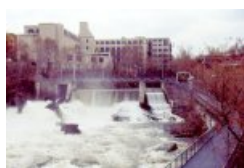
Construit vers 1910 sur la rivière Magog, à Sherbrooke, ce barrage en béton, de 90 m de long, possède une conduite d'eau (sous la promenade, à droite de la photo)
