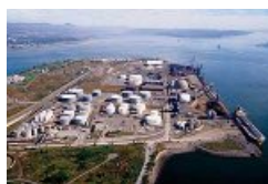
Vue aérienne oblique du port de Québec (Document 1)
