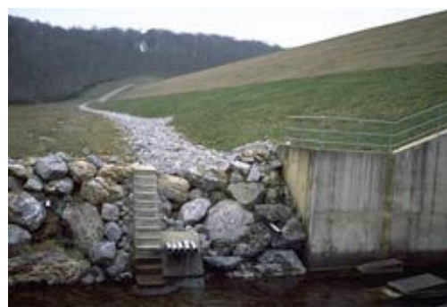
Fossé de drainage
