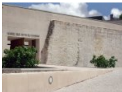
Adossé aux remparts ↗
