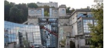
Façade de la bibliothèque - CIBDI
