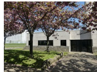
Entrée située à l'arrière du lycée
