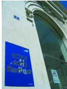
Mur extérieur, rue Léon Brédif
