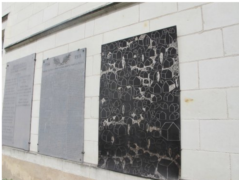
Pignon du bâtiment B
