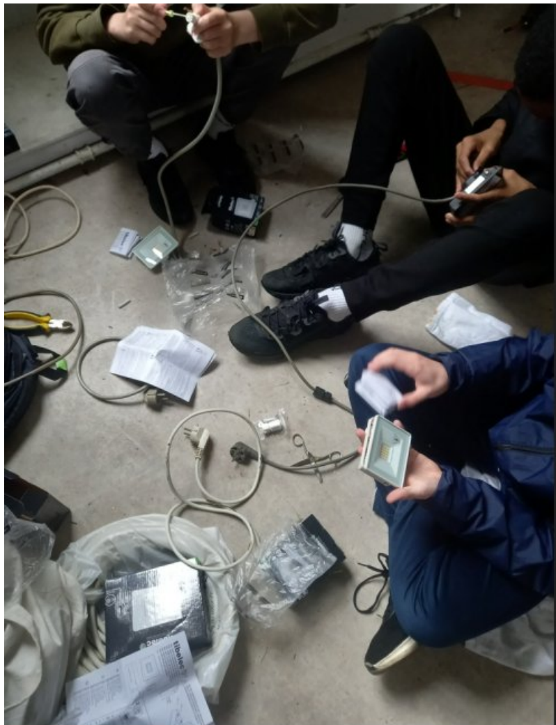
Installation des systèmes lumineux, un peu d'électricité avec le professeur de sciences physiques.
