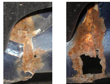
Corrosion superficielle en apparence
