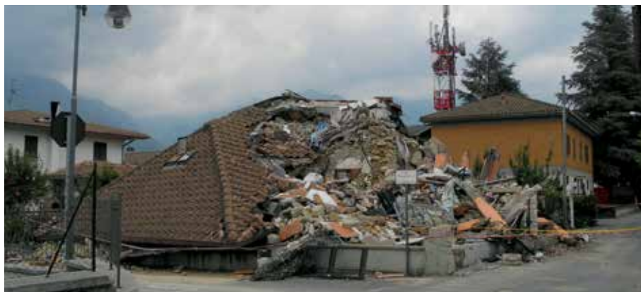
Une maison écroulée à Amatrice - 09/09/2016 © Marc Givry Architecte
