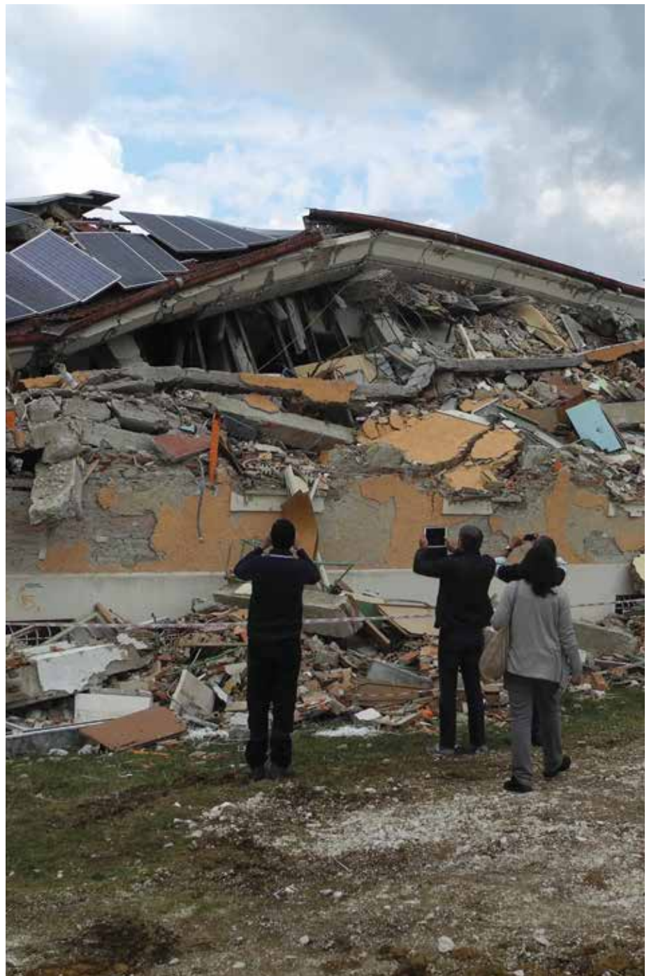
Hôpital d'Amatrice le 09/09/2016 © Marc Givry Architecte
