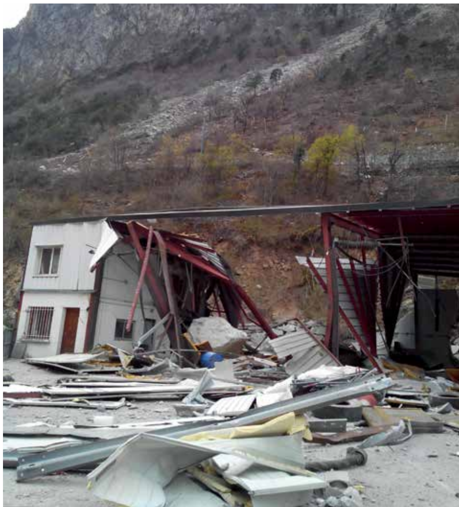
Chute de blocs en 2015, commune de Moutiers. © ONF-RTM73
