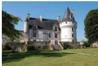
Façade nord du château de Crazannes © Château de Crazannes
