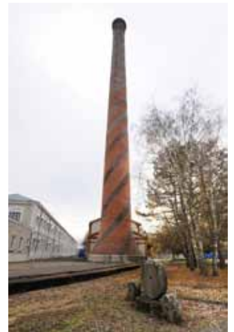
Cheminée de la manufacture d'armes de Châtellerault © SHD / D. Viola
