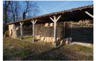
Halle de séchage de la tuilerie © Communauté de Communes des 4B
