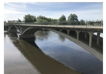
Pont Camille de Hogues 1900 Béton armé
