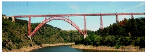
Viaduc de Garabit 1888 Métal
