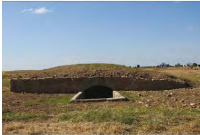
Le bunker, pour protéger de la bombe et de l'aviation, est construit en béton armé. Il mesure 10 mètres de diamètre. Il est construit en 1944 par les Artilleurs Français.
