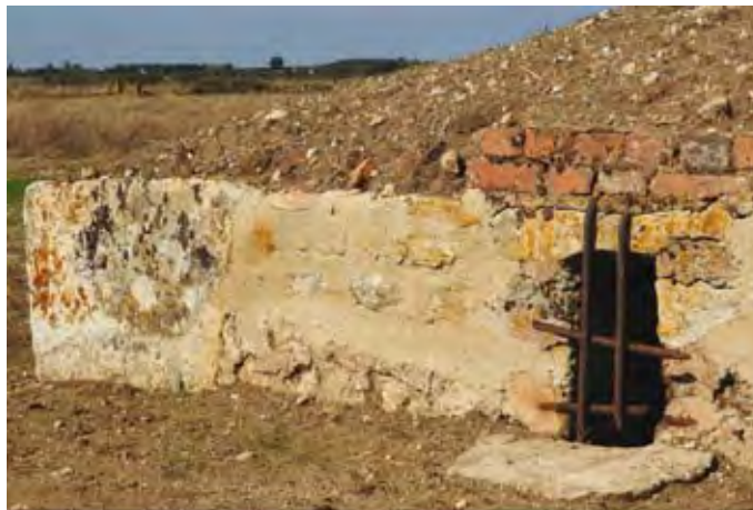
Le bunker est construit en pierre et en brique. Il mesure 10 mètres de diamètre. Il est construit en 1944 par les Artilleurs Français.
