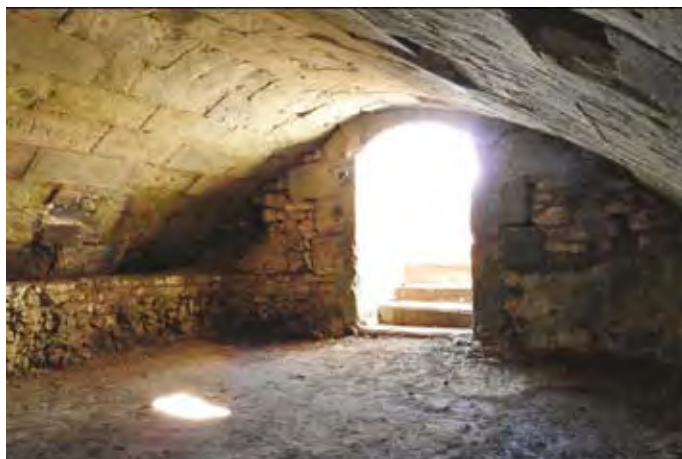
Le bunker est construit en pierre et en brique. Il mesure 10 mètres de diamètre. Il est construit en 1944 par les Artilleurs Français.
