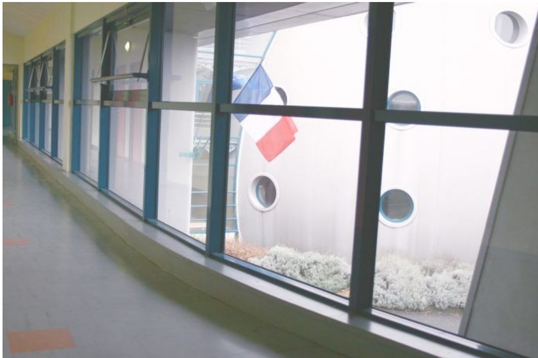
Vue du 1 er étage sur l'entrée du lycée
