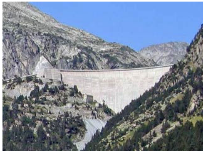
Le barrage de Cap de Long
