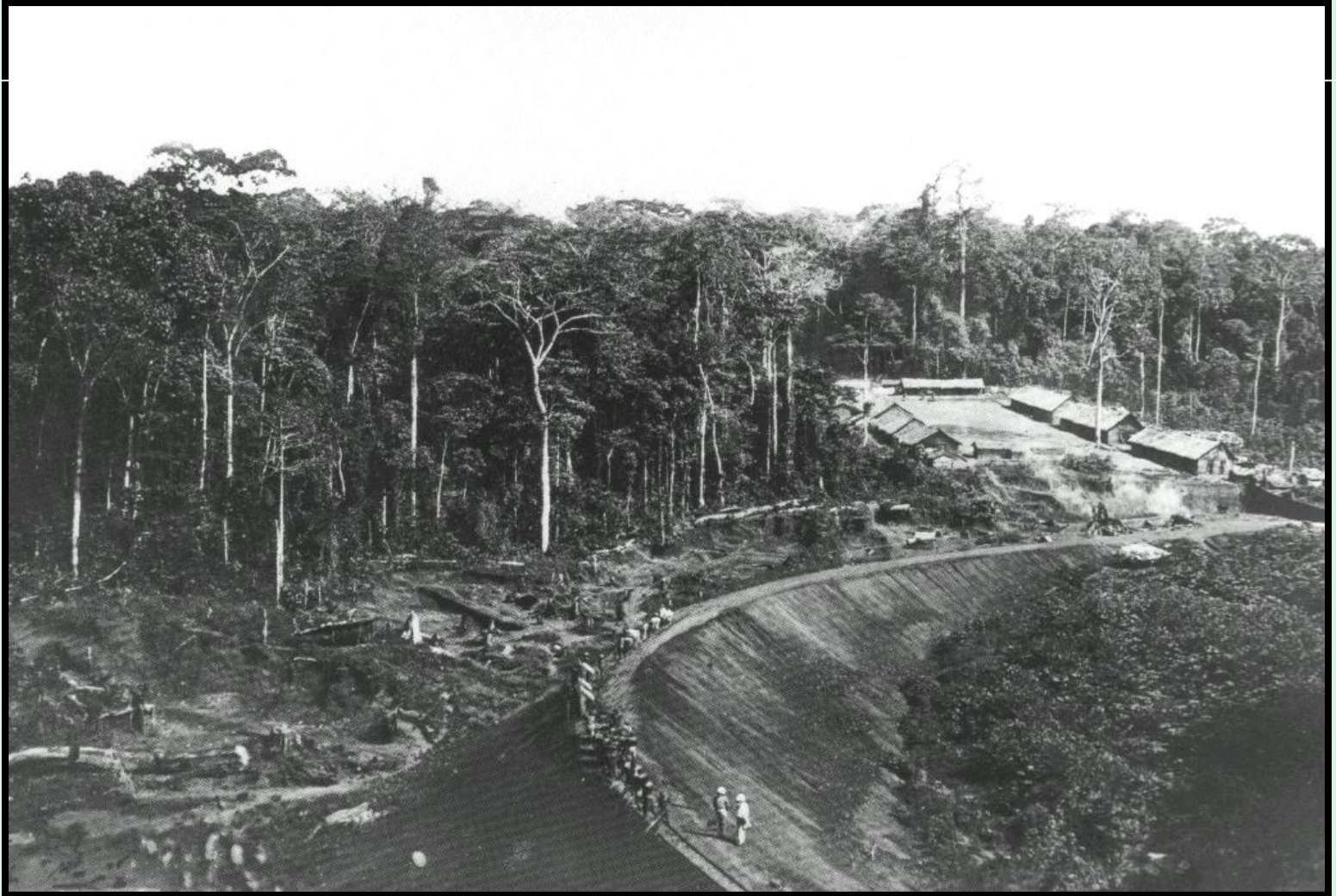
Construction d'une ligne de chemin de fer au Cameroun
