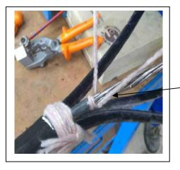
Retrait de la graisse recouvrant le neutre a l'aide d'une corde de bourrage.
