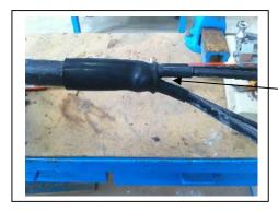
Finir pas chauffer le bas de l'E4R en allant du haut vers le bas pour evacuer les bulles d'air.
