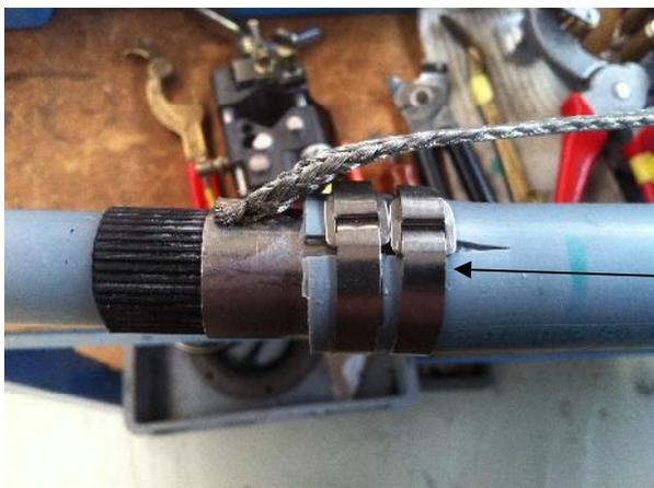
Mise en place des ligarex pour le maintien de la prise d'écran. Respecter les cotes indiquées sur la notice du constructeur
