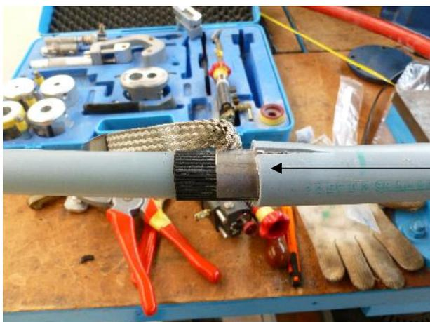
Ecarter et insérer la prise d'écran en respectant les cotes indiqués sur la notice de l'accessoire à réaliser
