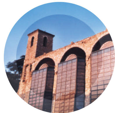
Photovoltaïque raccordé au réseau
