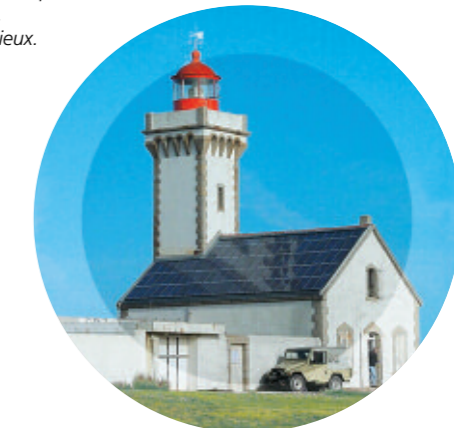
Installation de panneaux photovoltaïques en site isolé. Phare des Poulains à Belle-Ile-en-Mer.
