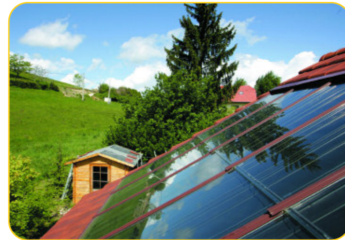
Installation d'un chauffe-eau solaire chez un particulier en Savoie.
