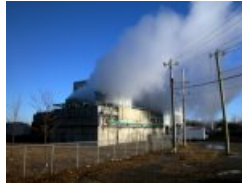
Complexe environnemental de Saint-Michel, 2335, rue Michel-Jurdant (Montréal) Photo de Denis Chabot, Denis Chabot @ images du Québec, CCDMD, 1900 x 2500 cm La centrale, aménagée aux abords du site d'enfouissement du quartier Saint-Michel, transforme les biogaz en électricité. (environnement, recyclage, développement durable, pollution, énergie)
