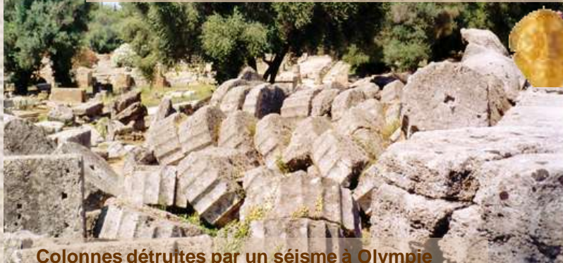
Colonnes détruites par un séisme à Olympie
