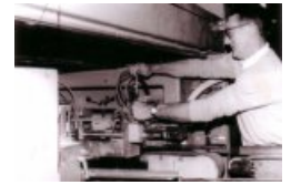
Ouvrier - Usine Jean Ranger ↗
