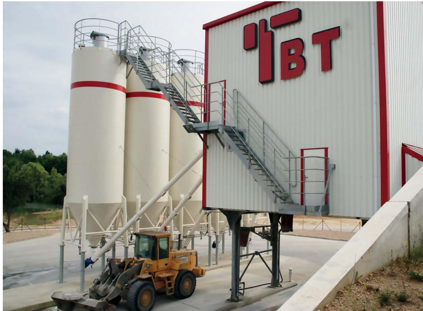
Béton industriel et laboratoire d'essais.
