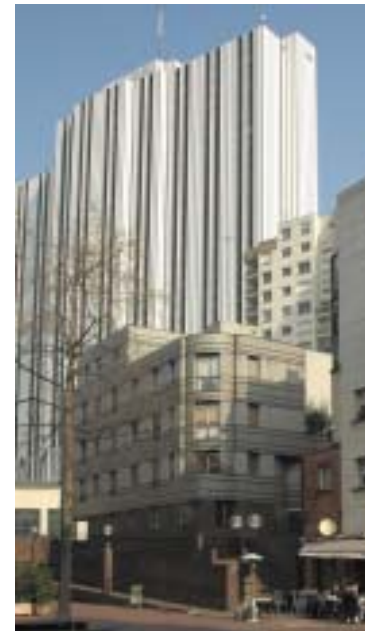
L'immeuble-tour crée une rupture d'échelle dans le tissu urbain du quartier Montparnasse à Paris.
