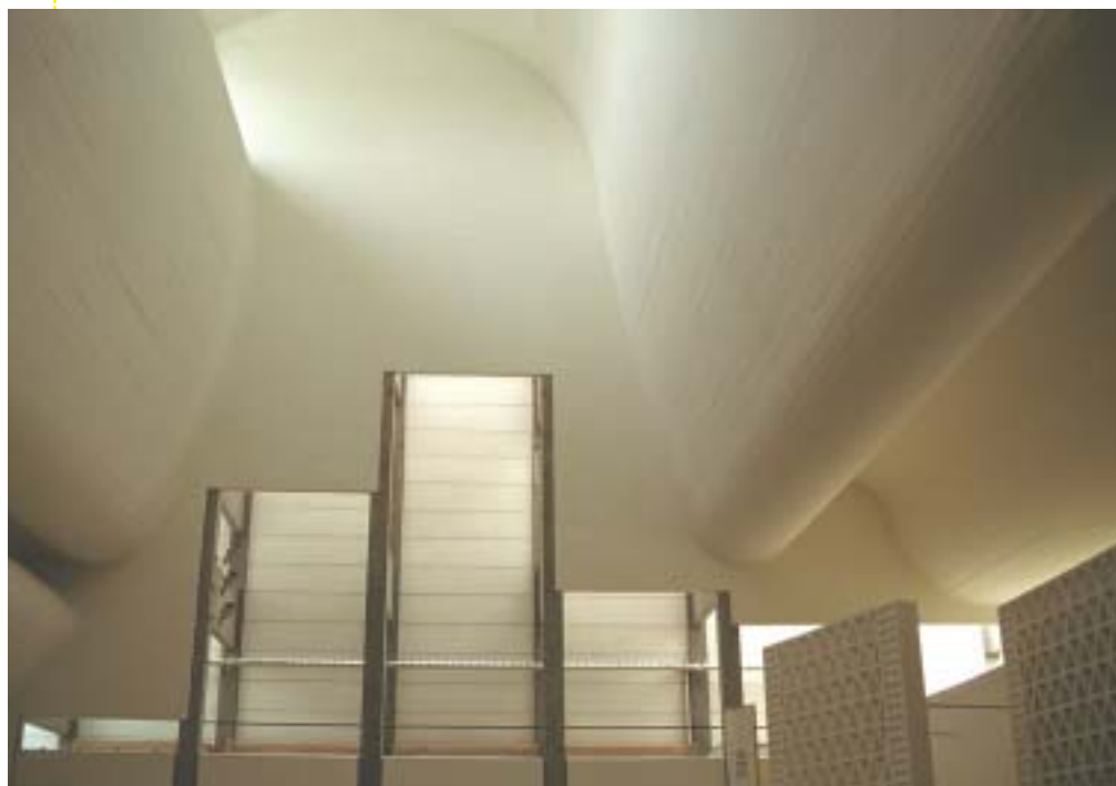
Le plafond s'incurve en grandes vagues qui vont chercher la lumière zénithale. Église à Copenhague, Jorn Utzon.
