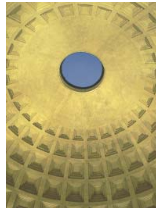
Une grande coupole à caissons éclairée par un oculus de 9 mètres de diamètre. Panthéon à Rome (II e siècle après J.-C.).
