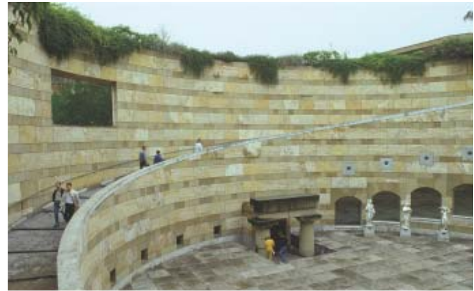
La promenade architecturale, un thème récurrent de la modernité. La Staatsgalerie à Stuttgart, James Stirling.
