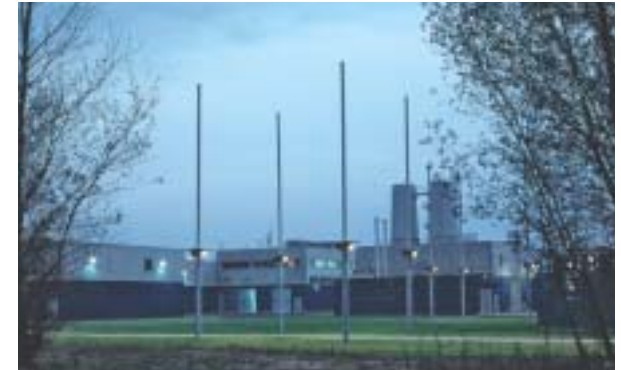
Des équipements techniques au service de la ville. Usine de traitement des eaux à Begles (33), Jean de Giacinto.
