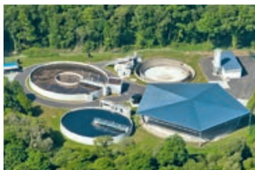
Station d'épuration. © Laurent Mignaux.
